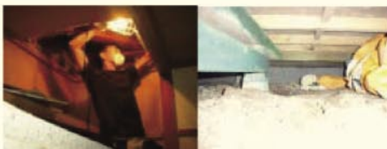
小屋裏の確認
