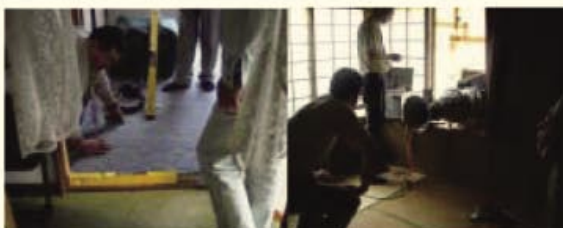
床の傾斜測定
