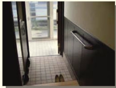
手摺りの設置
