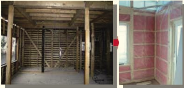
新しい断熱材の追加と気密シートの施工
