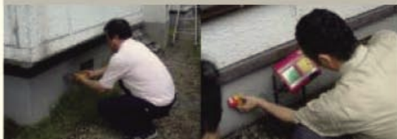
基礎強度確認
